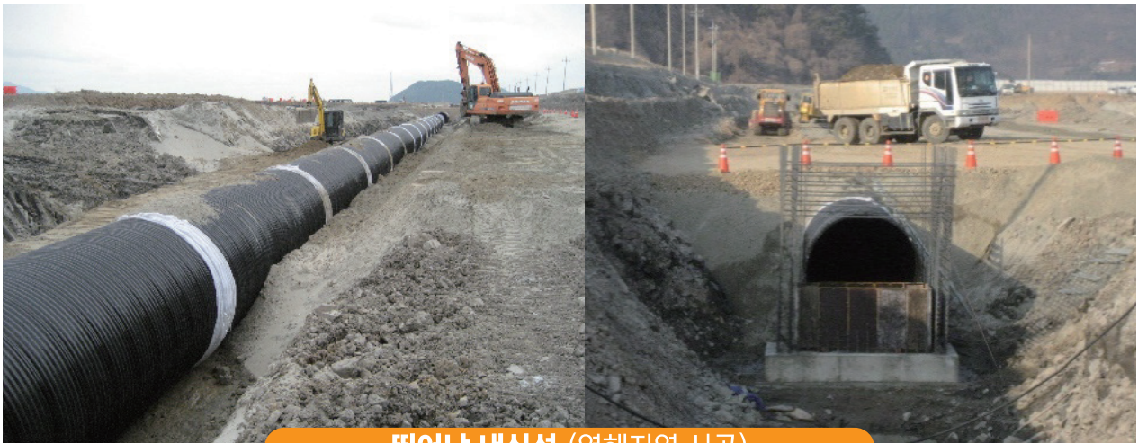
뛰어난 내식성 (염해지역 시공)
